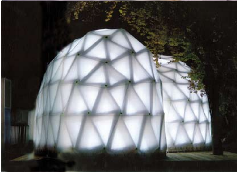
TECHNO IGLOO/ Cartone e membrane in Pvc sono gli elementi base del padiglione temporaneo, firmato da Oliver Fritz & Tom Pawlofsky in collaborazione con gli studenti della Hochschule del Liechtenstein. Un progetto low price pensato per essere un teatro e costruito all'occorrenza con facilità.
